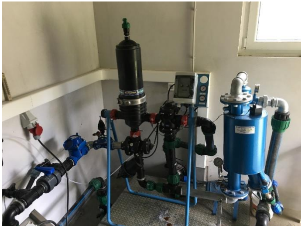
Fertigacijska in čistilna naprava za namakanje jabolk
